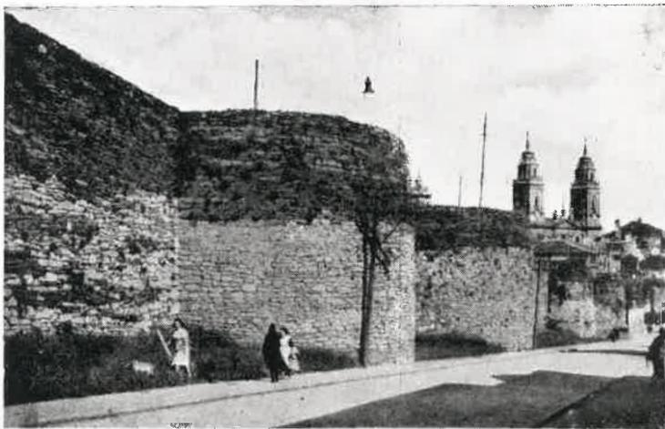
Todo el perímetro de la Muralla estuvo flanqueado por bastiones semicirculares de gran radio y robustez. El perfil de esos cubos puede apreciarse en esta fotografía, tomada poco antes de las obras de limpieza y supresión de los postes existentes sobre el monumento
