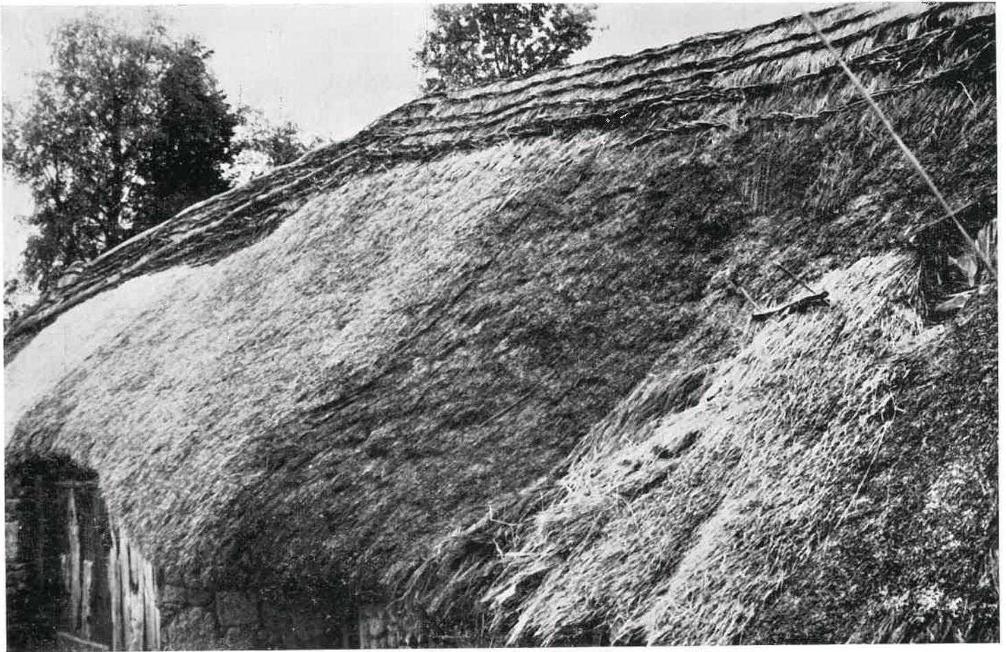
Cubierta de una de las pallazas y sistema constructivo de sus muros. Nótese el pequeño hueco para ventilación. En la fotografía de abajo, detalle de la estructura constructiva de uno de los tejados cónicos del poblado
