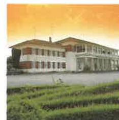
Fachada del Hospital Psiquiátrico
