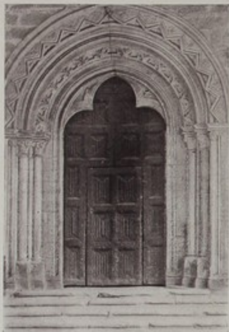
Puerta de la Iglesia de San Francisco, del siglo XIII (Foto. Gasalla)
