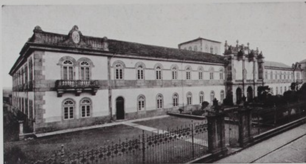
Fachada principal del Palacio de la Diputación
