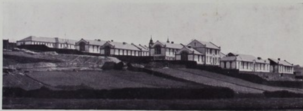
Vista de conjunto, del estado actual de las obras, tomada el día 9 de abril de 1929
