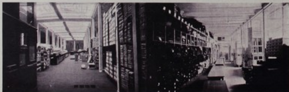
Una de las naves de los almacenes
