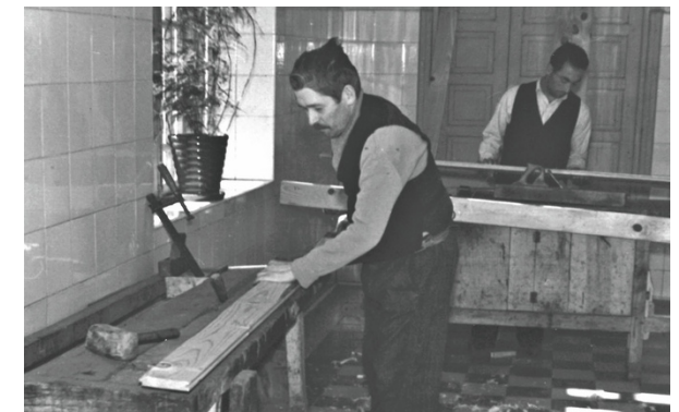
Obras en el Hospital Psiquiátrico de San Rafael (s.d.) ADPL sig3331.108
