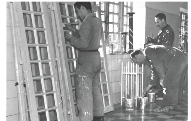
Obras en el Hospital Psiquiátrico de San Rafael (s.d.) ADPL sig3331.106
