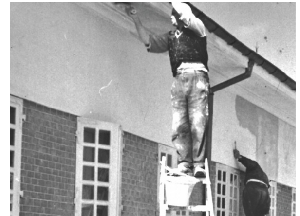
Obras en el Hospital Psiquiátrico de San Rafael (s.d.) ADPL sig3331.107
