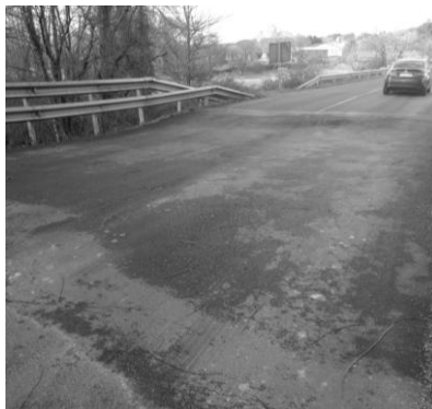
Fotografía en la que puede apreciarse el hundimiento de calzada
