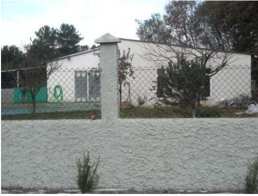
Foto 7 Cierre de bloques y celosía
