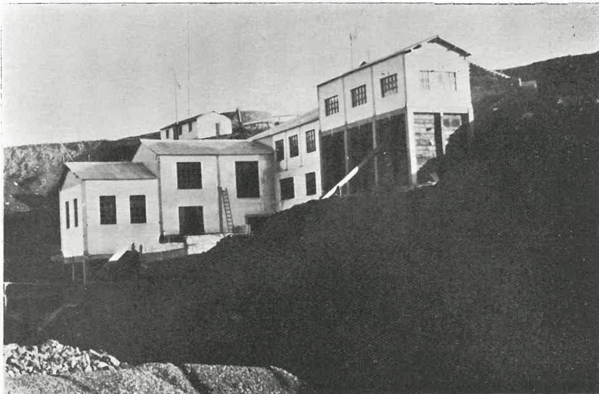
Lavaderos y depósitos de material de hierro que en Irijoa, en las cercanías de Guntín, ha instalado MINAS DE GUNTIN, S. A.
