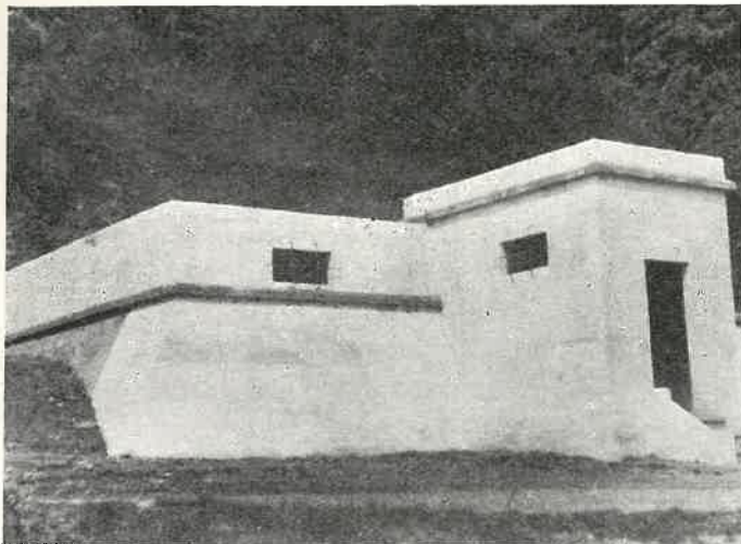
Depósito de aguas, de reciente construcción, mediante el cual se abastece a la villa y a los servicios municipales correspondientes
