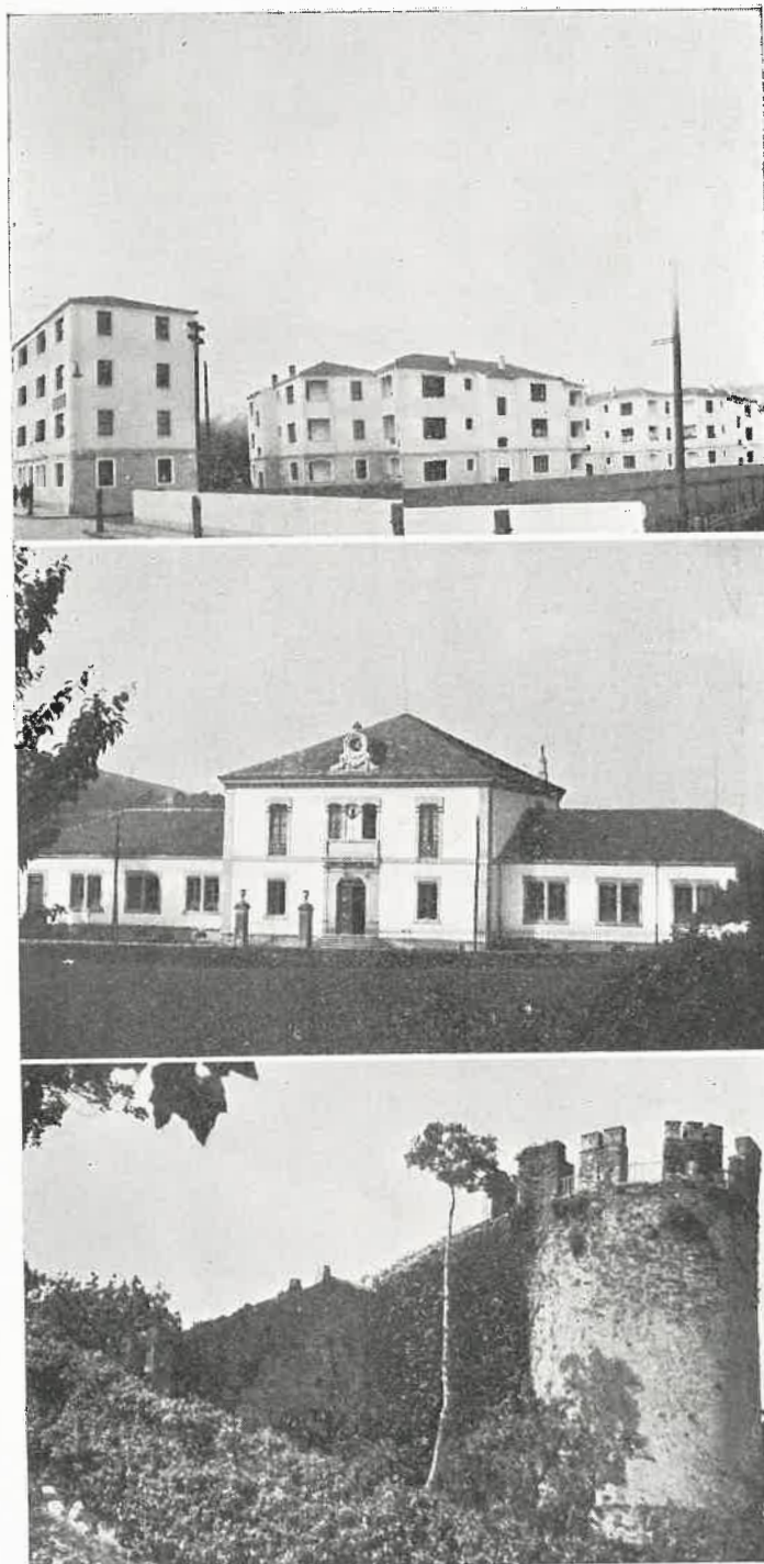
Foto 1.—Grupos de nuevas viviendas. Foto 2.—Grupo escolar «Matías López». Foto 3.—Restos de la fortaleza de la villa.
