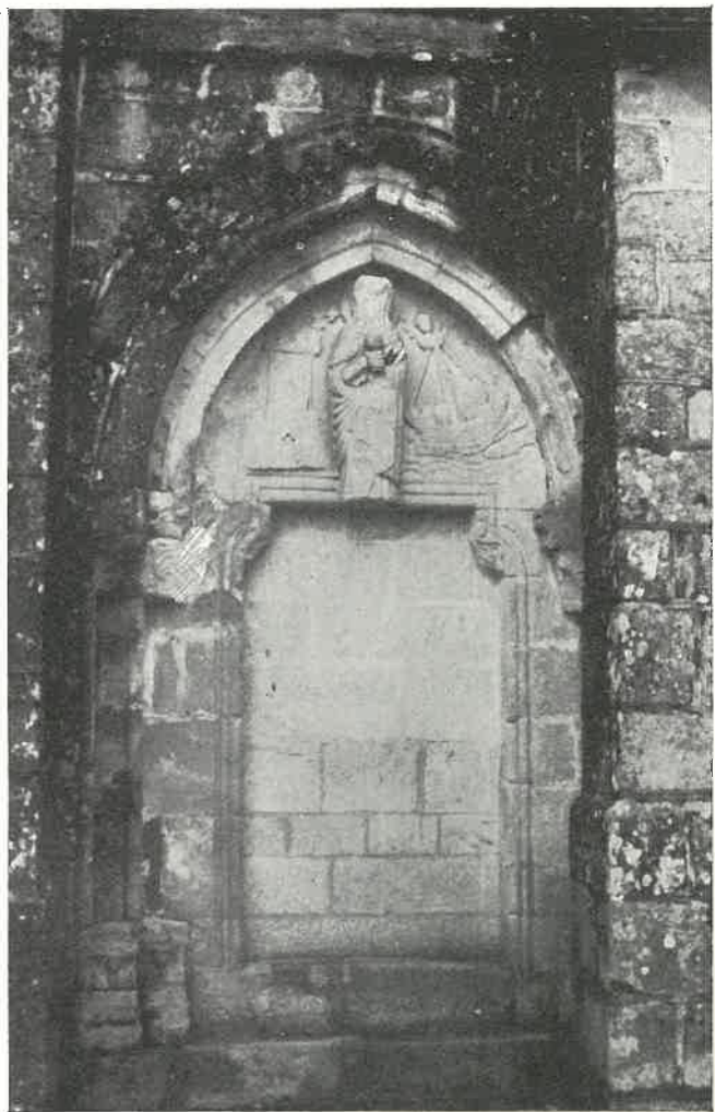
Puerta recientemente descubierta en la iglesia conventual
