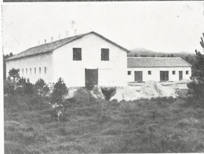
Aspectos de conjunto y parcial del albergue de ganado construido en la «Fraga Vella». El edificio ha sido estudiado para una doble fila de plazas de tipo corto y pasillo central de alimentación. En él se han instalado diversas dependencias y la planta superior está destinada a henil
