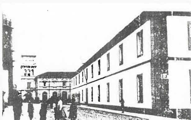
CUARTEL DE SAN FERNANDO
