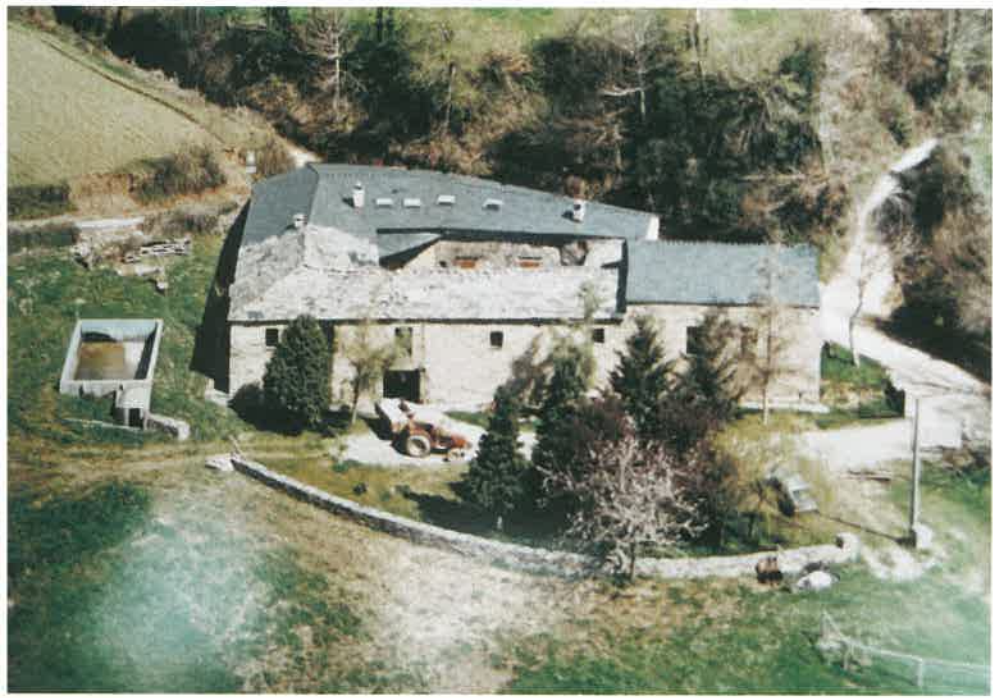
Otra vista de la casa cuando todavía no estaba totalmente rehabilitada
