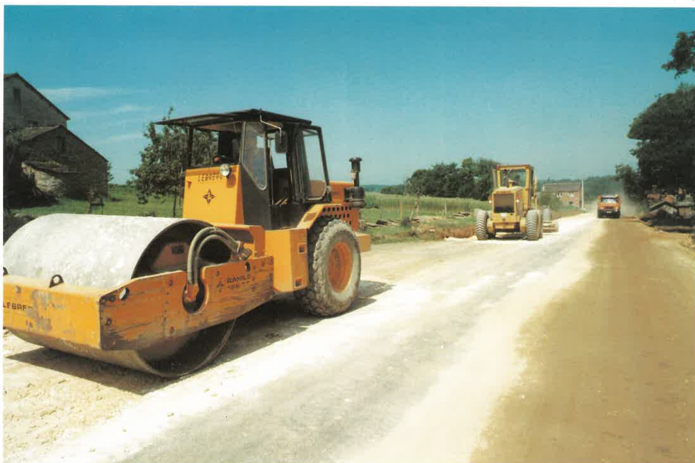
Obras en la Ctra. de Villalba a Feira do Monte.
