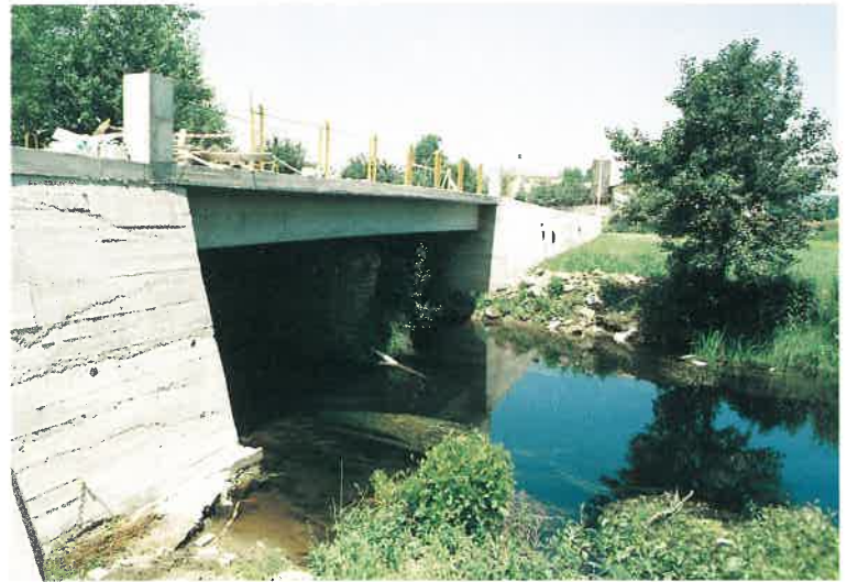
Puente en carretera Sarria a Celligos
