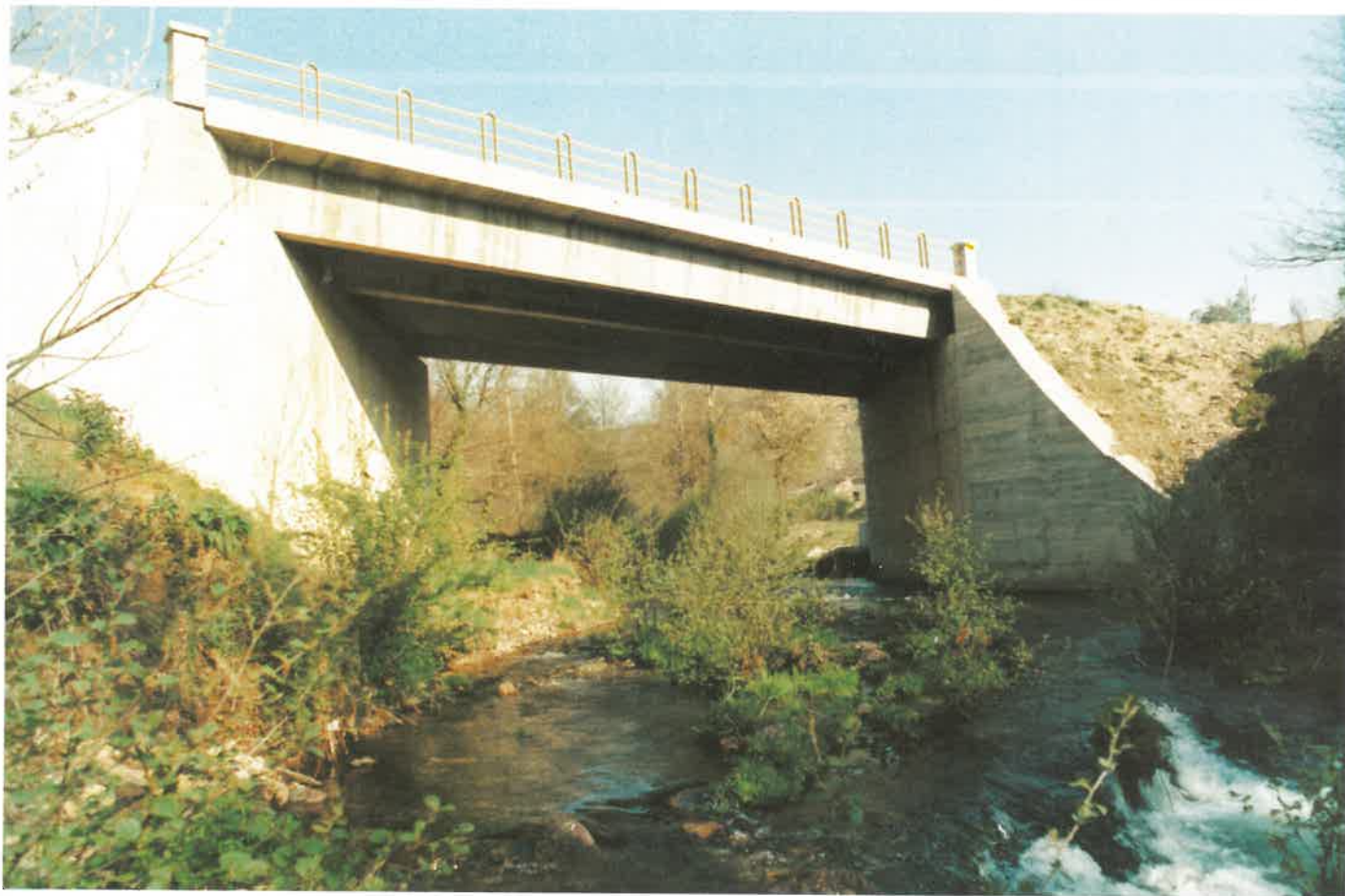
Puente de intersección entre la Ctra. de Baralla a Meira a la de Cerezal-Louxas
