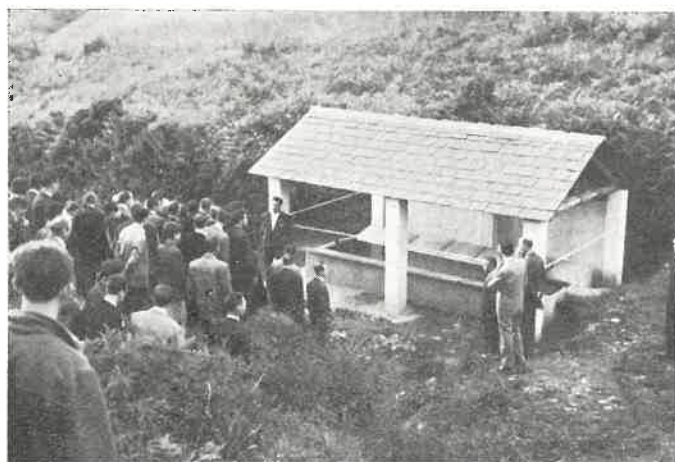
Como una de las realizaciones del Plan bienal, y como ejemplo de lo que los Ayuntamientos pueden realizar mediante la ejecución de este plan, publicamos la fotografía que recoge la inauguración de un lavadero público en el término municipal de Baleira, acto celebrado en el presente mes.
