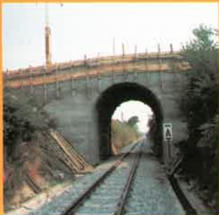
Reconstrucción de puente en vía férrea (Cangas-Foz)
