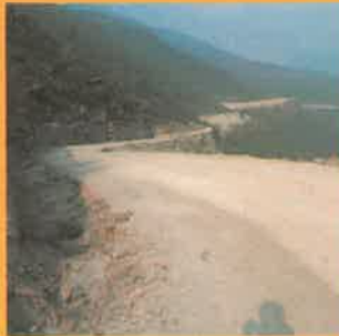
Carretera de Samos a Caurel, obra de reciente realización
