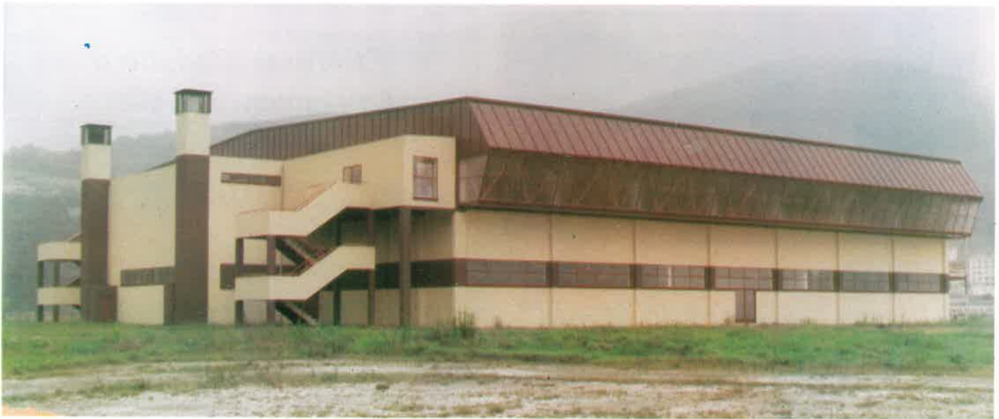
Nuevas instalaciones deportivas (Vivero)
