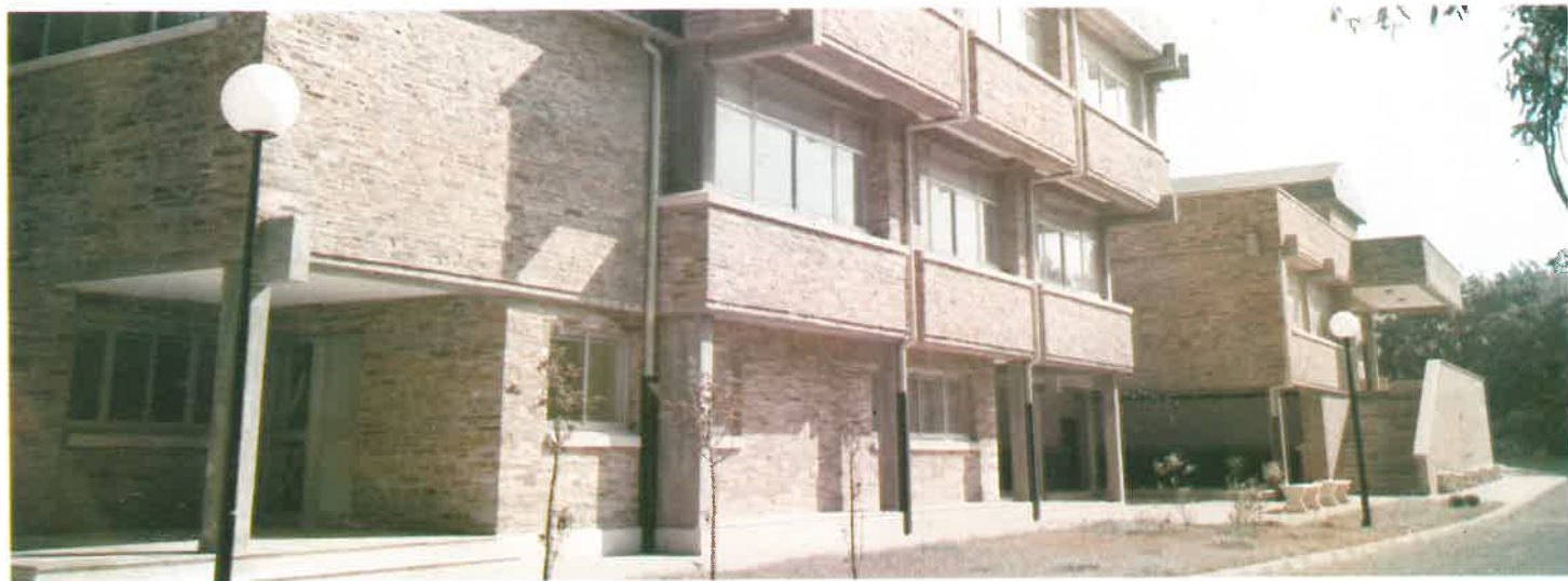
Edificio del Colegio Universitario de Lugo, situado en Fingoy, destinado a albergar la Facultad de Veterinaria, ha supuesto una inversión 245.150.846 pesetas
