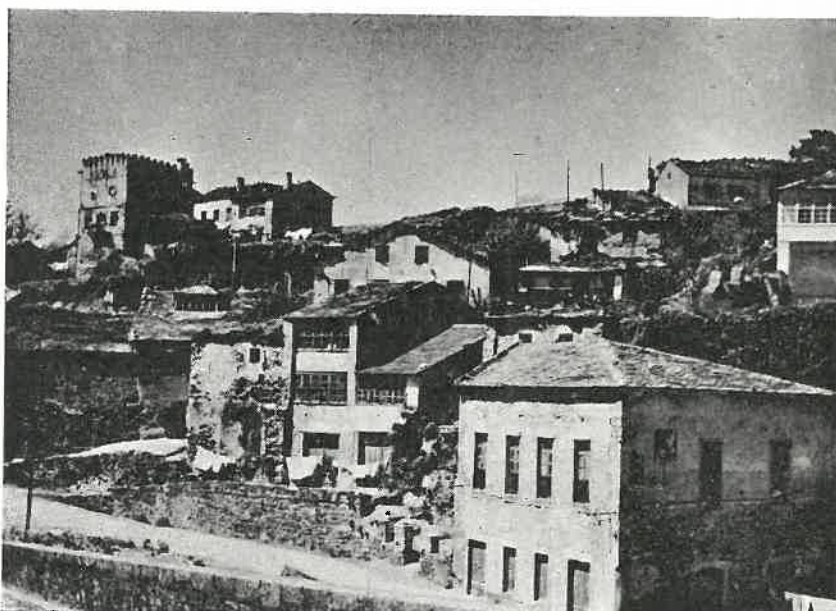
Recuerdo del viejo Ribadeo, que conoció esplendores y luchas, quedan, en las lomas que descienden hacia el mar, edificaciones que nos hablan de los viejos tiempos, con almenas y miradores, con tapias y huertos. Resumen del Ribadeo trabajador y heroico es la fotografía que ilustra estas páginas.
