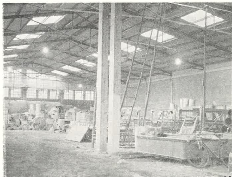
Aspectos diversos del interior y exterior de la fábrica
