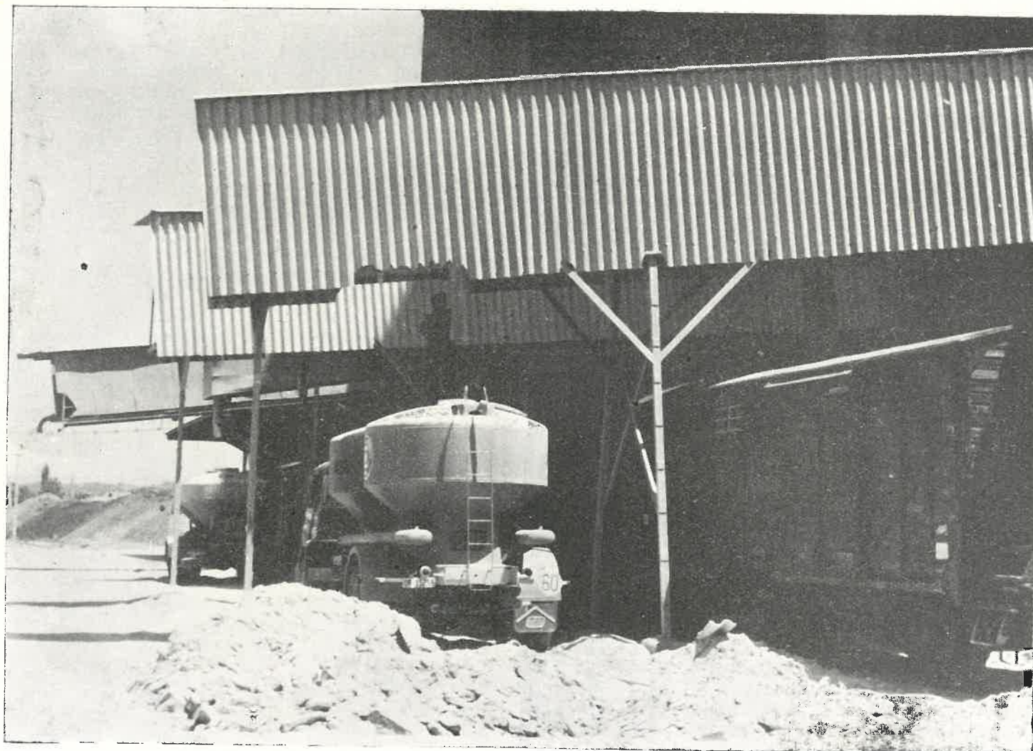
Dos camiones tolvas, de la flota de 15 con que cuenta la fábrica de Oural, son cargados, mediante las instalaciones automáticas de la factoría, con cemento en polvo. El pabellón de carga permite la simultánea de vagones y camiones con cemento ensacado, para ser llevado a diversas partes de España. El transporte del cemento a granel es más económico y permite a las empresas constructoras un más fácil aprovechamiento y una menor pérdida de materia
