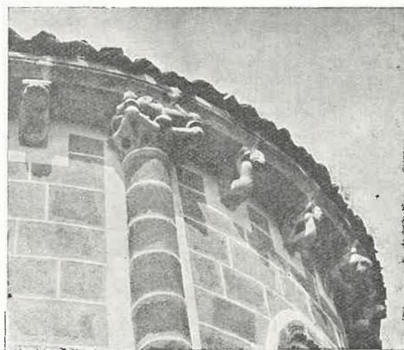
Detalle del abside
