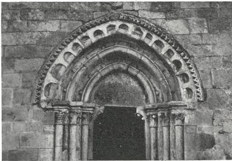
Detalle de las arquivoltas de la puerta principal. Las dos fotografías de la parte superior de esta página corresponden a sendos ventanales calados de la iglesia
