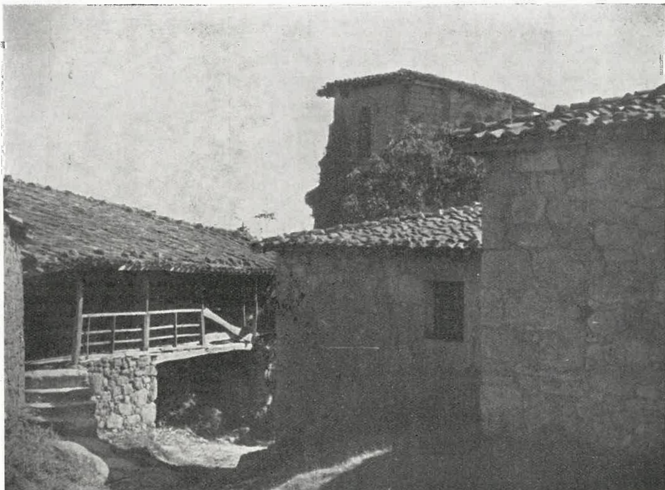
Por tierras de Pantón es fácil descubrir bellos rincones en los que la arquitectura antigua suma los recios sillares de los edificios a las balconadas de madera, bañadas por el sol
