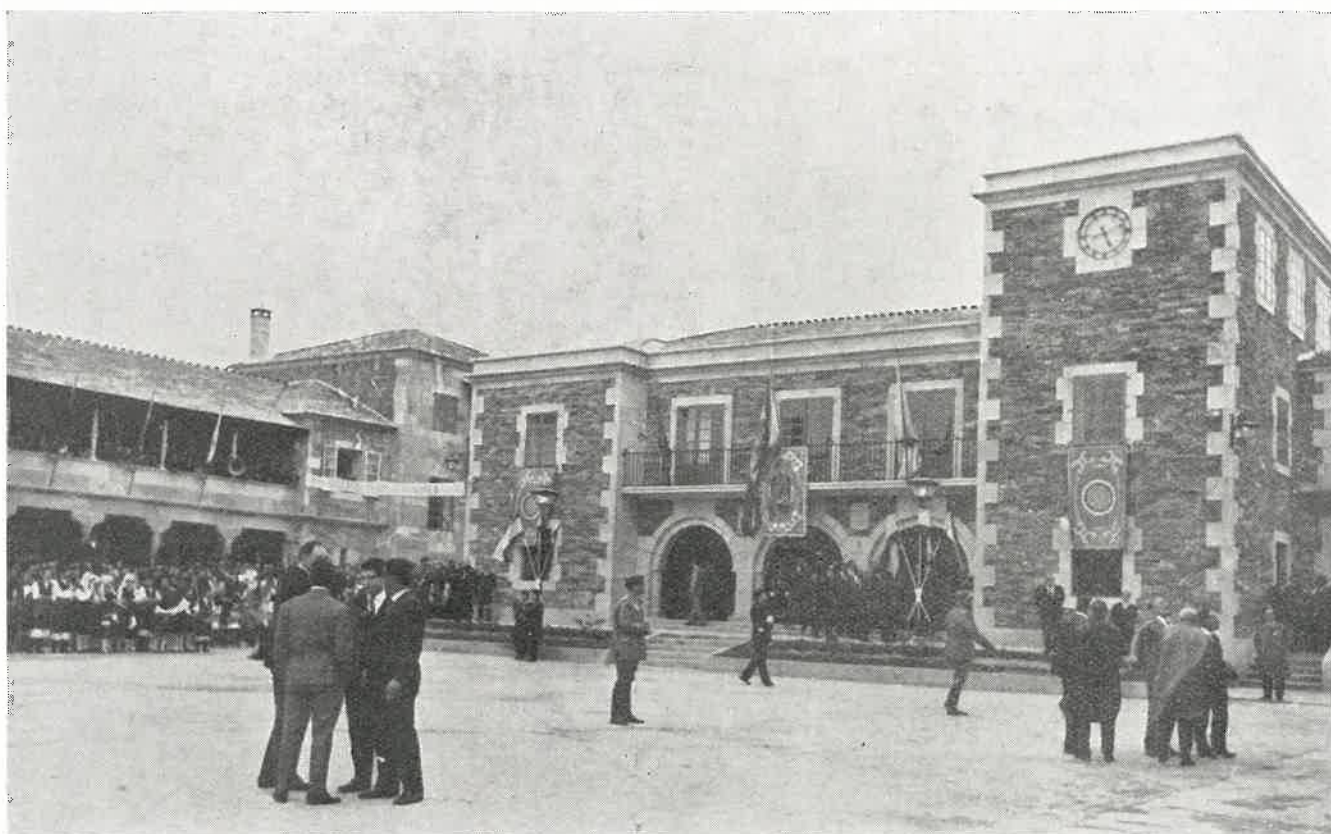
La nueva Casa Consistorial, construída en uno de los lados de la plaza central. En ella funcionan también los servicios de Correos. En otro de los lados, los porches de la Casa del Conde y sus balconadas, trasladados al nuevo emplazamiento, prestigian esta plaza, que es una de las más atractivas de la provincia
