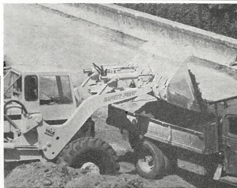
Foto I.—Dos aspectos de la pala cargadora
