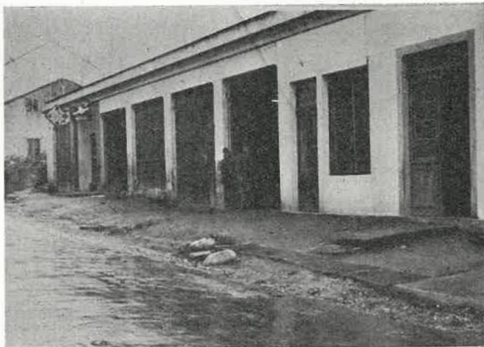
Vista exterior de una de las naves de los talleres mecánicos de Viuda e Hijos de José Martínez
