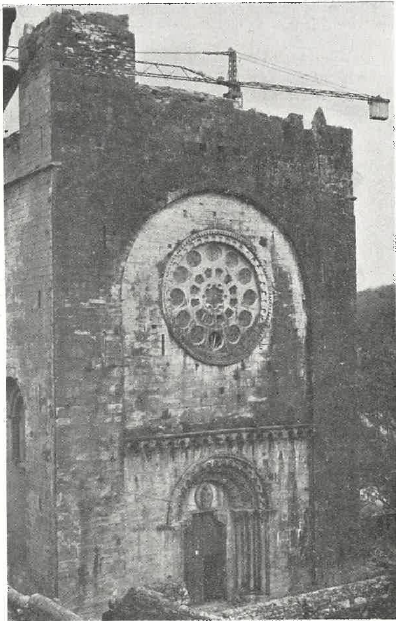
La fachada de la iglesia de San Juan, en el momento de ser iniciadas las obras para su traslado al nuevo emplazamiento
