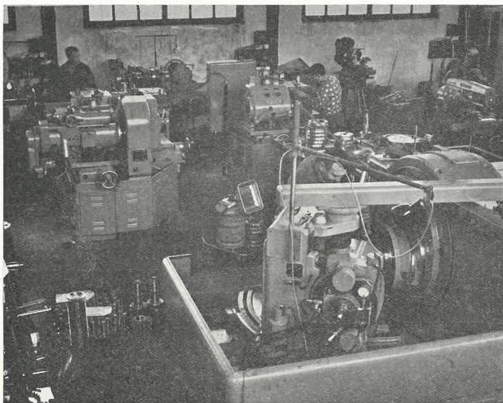
El modernísimo equipo de maquinaria «Gleason», utilizado especialmente para la fabricación de grupos cónicos, está formado por diversos elementos, algunos de los cuales figuran agrupados en esta fotografía. El mando electrónico de estas máquinas permite una perfecta y rápida fabricación de las piezas
