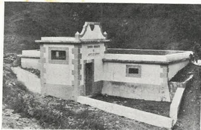
Un aspecto del depósito de agua recientemente construido
