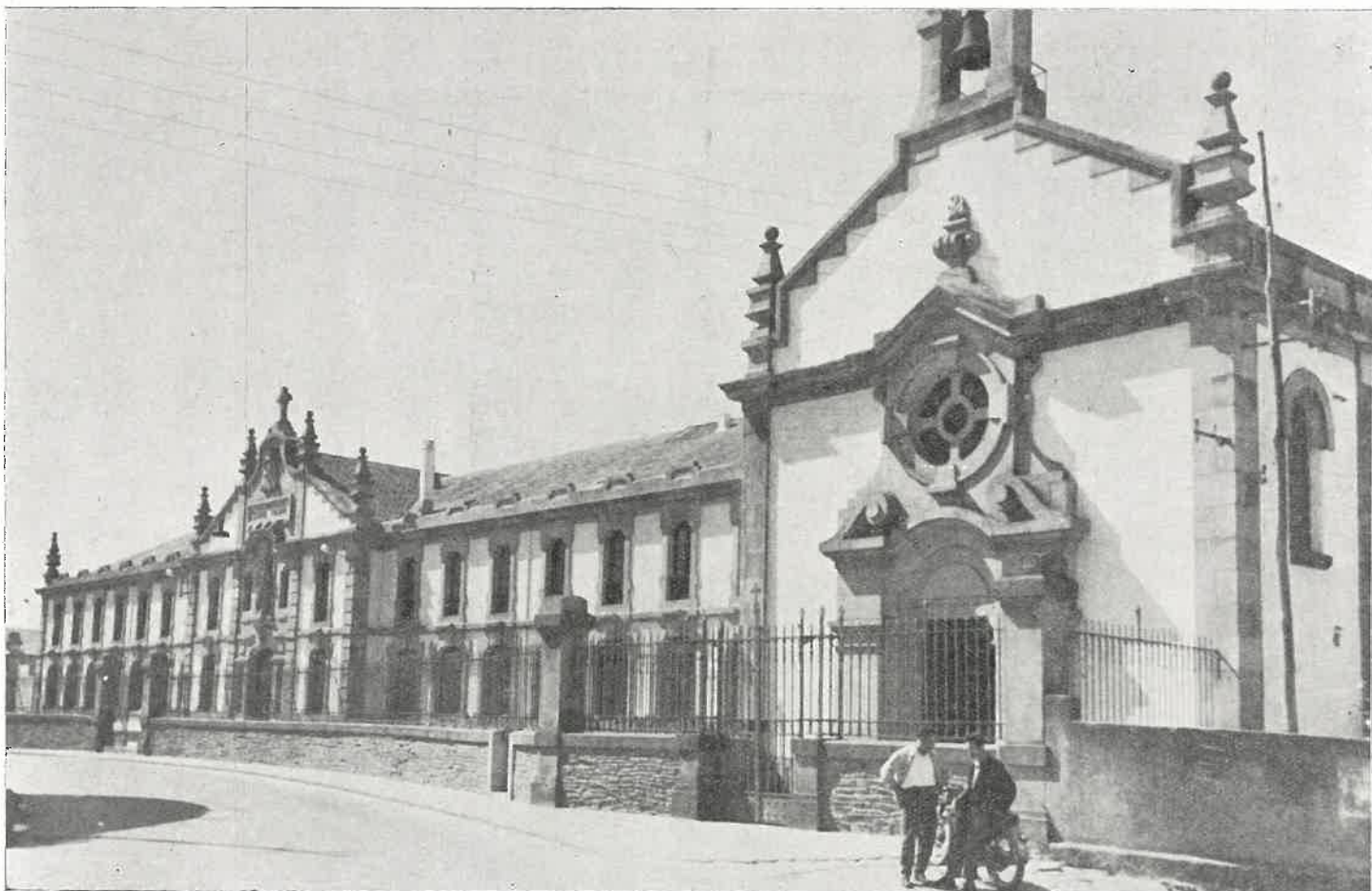
Vista de conjunto de la fachada y capilla del Hogar provincial de Santa María
