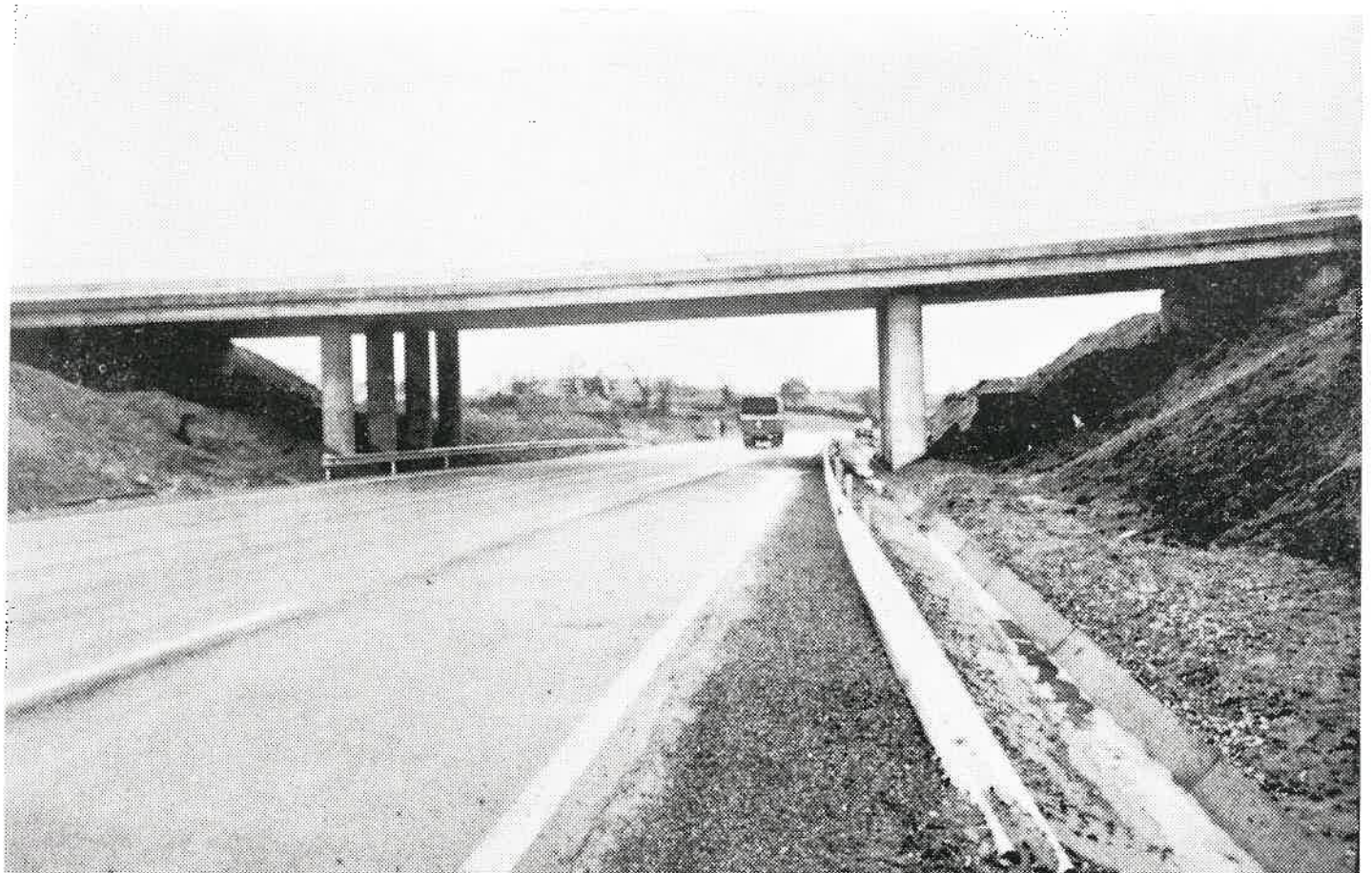
Foto 1.—Próxima a la Estación de Servicio en las cercanías del Alto de Garabolos se inicia la vía de acceso a Lugo viniendo de La Coruña y la vía que desde aquí conduce a la Tolda de Castilla. En la fotografía puede apreciarse el paso elevado que enlaza la carretera Madrid a La Coruña con el nuevo acceso, mediante la construcción de un puente. Foto 2.—Aspecto que ofrecen el puente y la carretera que bajo él pasa. El puente es una de las importantes obras de fábrica que forman parte de los nuevos accesos a Lugo y que tantas ventajas han reportado para la circulación y para la ciudad
