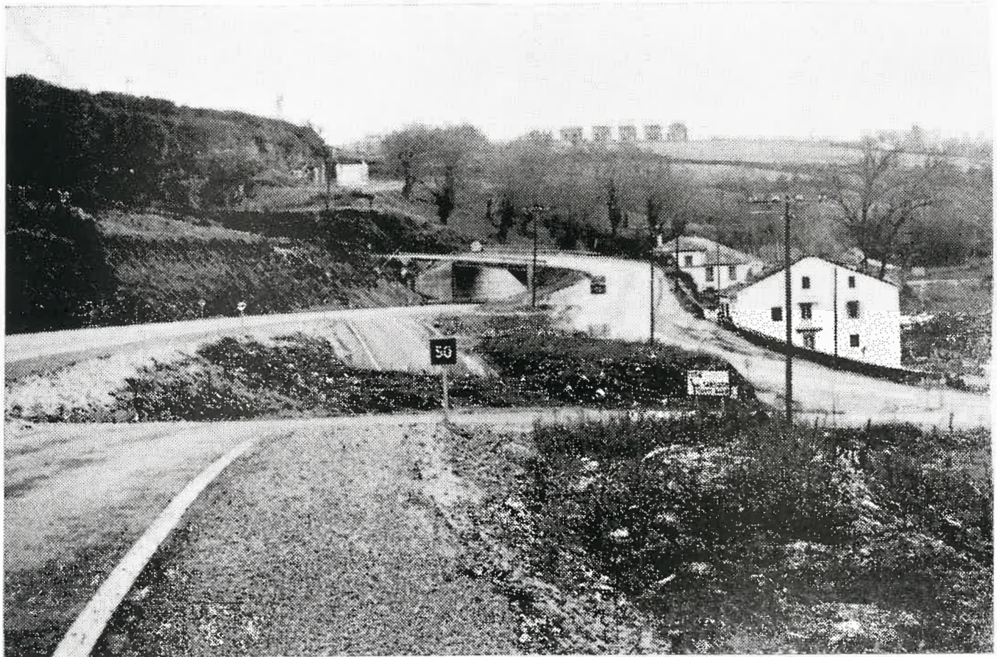
El acceso a Lugo, desde el puente romano, se ha logrado creando en el Barrio del Puente unos enlaces con la carretera de Santiago y con la vía que sigue el cauce del Miño. Aquí fue necesario construir un puente sobre el que pasa el acceso a la ciudad y bajo el cual pasa la referida vía. La fotografía ofrece una panorámica de las obras realizadas.
