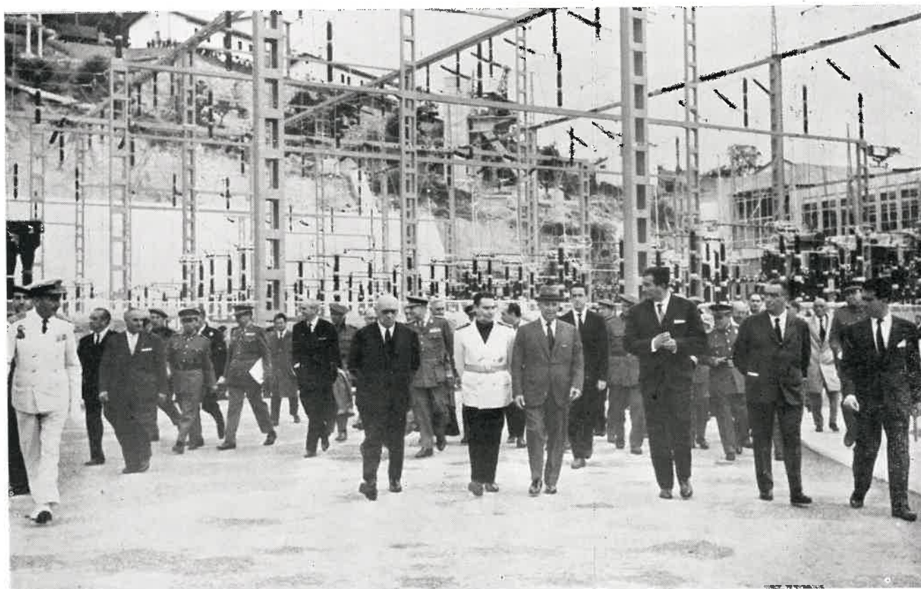
El día 10 de septiembre de 1963 hizo una visita el Caudillo al Embalse de Belesar. Las fotografías recogen el momento en que el Jefe del Estado escucha las explicaciones de los técnicos en relación con las características del embalse que iba a ser inaugurado, y la visita hecha a la estación de transformación de la central
