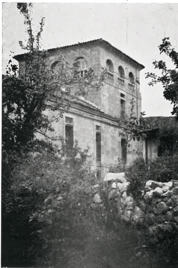
Foto 1.—Fachada principal del Monasterio. Foto 2.—Bello aspecto del ángulo Norte del edificio monasterial
