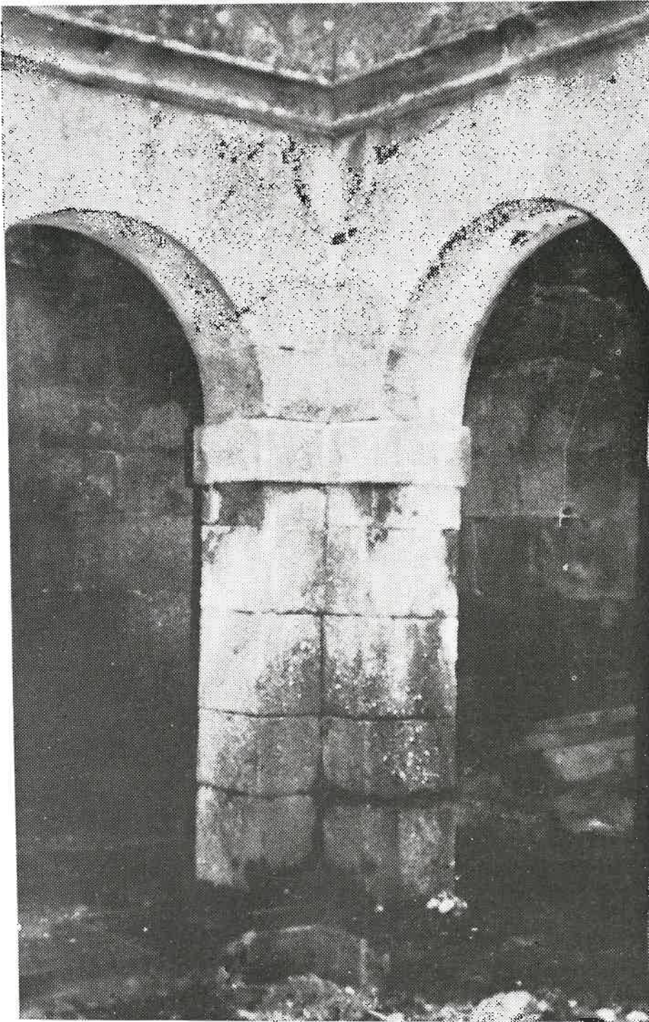
Como un símbolo de los tiempos en que la comarca de Friol era el lugar donde señores e hidalgos construían sus fortalezas y viviendas, este ángulo del patio interior de la torre de Xiá o fortaleza de San Payo de Narla ofrece la robustez de sus sillares y el perfecto dovelaje de sus arcadas
