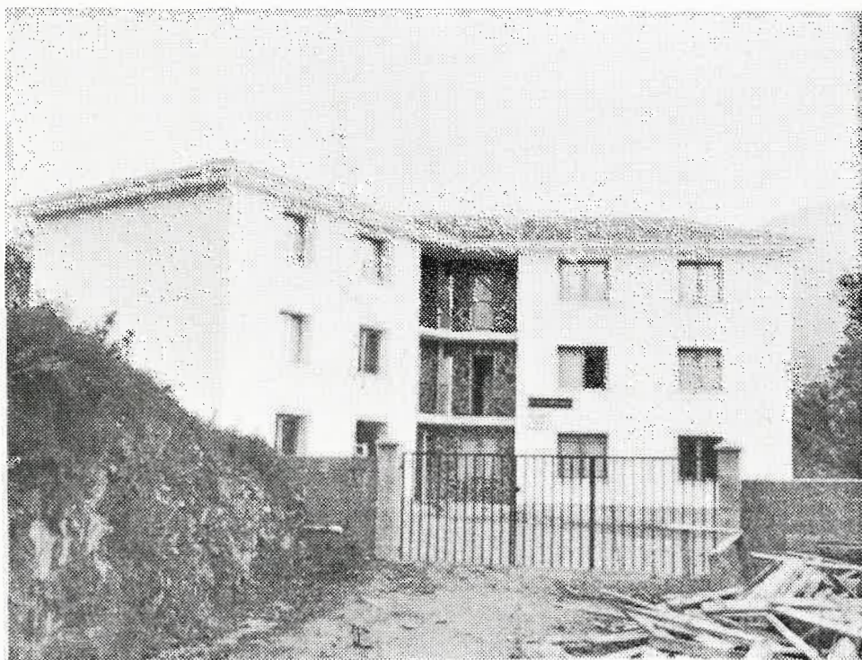
Un aspecto de la Casa Cuartel de la Guardia Civil en Folgoso
