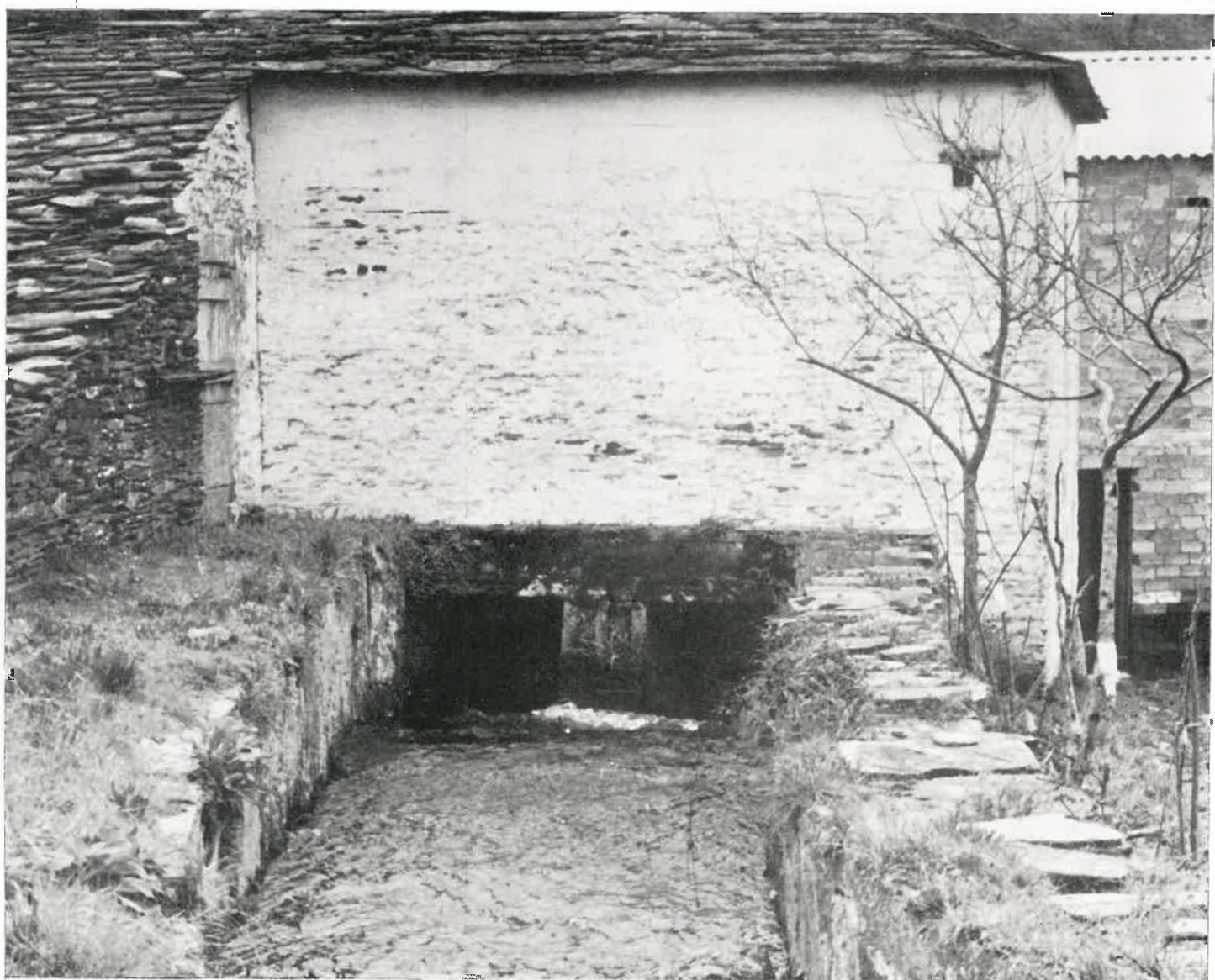
Foto 1.—Canal de entrada del agua al RODICIO o rueda motriz, turbina con aspas de madera o hierro. Foto 2.—Canal de salida del agua en un molino DE DUAS PEDRAS o de equipo doble de molturación
