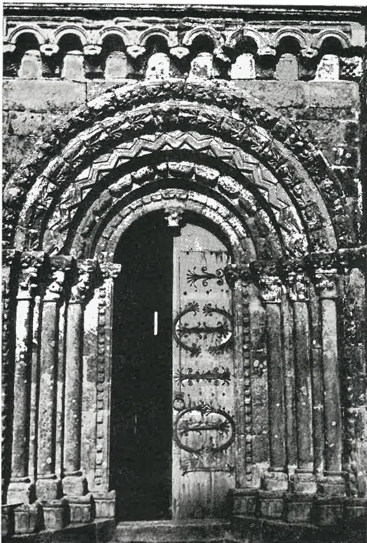
Puerta de entrada de la iglesia románica de Villar de Donas, en el Camino de Santiago, por tierras de Palas de Rey. Además de la variedad de ornamentación de las archivoltas, son de destacar los herrajes de las puertas, tan parecidos a los de la Puerta Norte de la Catedral de Lugo y a algunos de los que adornan la puerta principal de la de Meira
