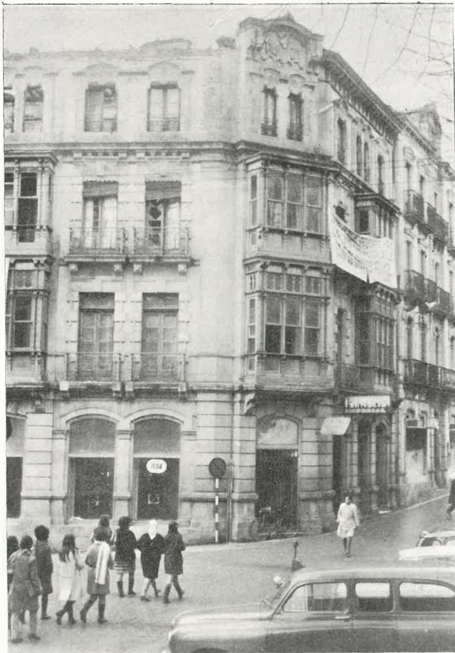
La Caja de Ahorros provincial ha adquirido este edificio, situado en la Plaza de España, para proceder a su demolición y levantar en su solar la sede social de la institución. El edificio actual sufrió hace algún tiempo un incendio, que le ocasionó numerosos daños
