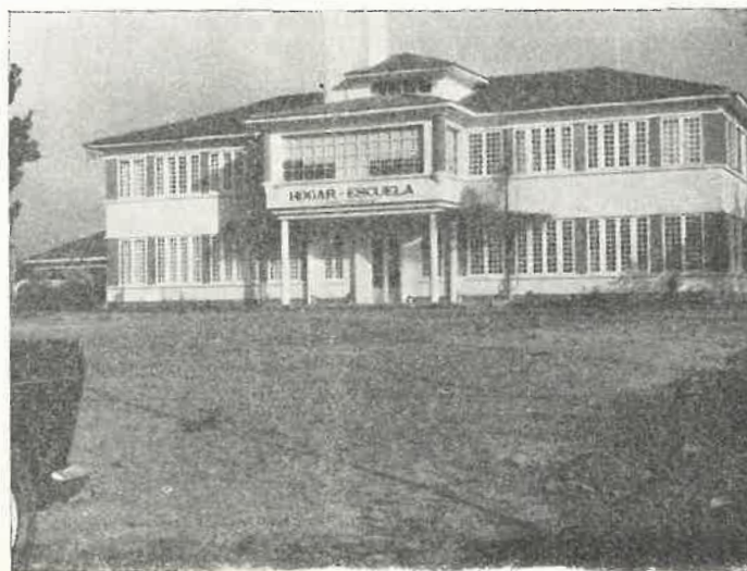
HOGAR ESPECIALIZADO DE SUBNORMALES. —Se halla emplazado este edificio a la izquierda de la carretera "Del Pontón de la Gulpilleira a Gontán", términos del lugar de Castro de Riberas de Lea, en el Ayuntamiento de Castro de Rey (Lugo); dispone de una planta edificada de 575 metros cuadrados al que son anejas diversas dependencias auxiliares. Actualmente está ocupado por la Asociación provincial de Padres de Niños y Adolescentes Subnormales de Lugo
