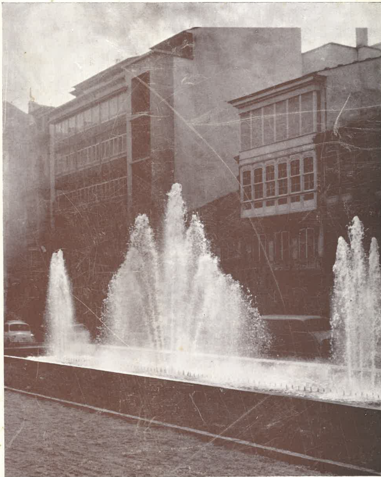
UNA DE LAS FUENTES LUMINOSAS INSTALADAS FRENTE AL PALACIO PROVINCIAL.
