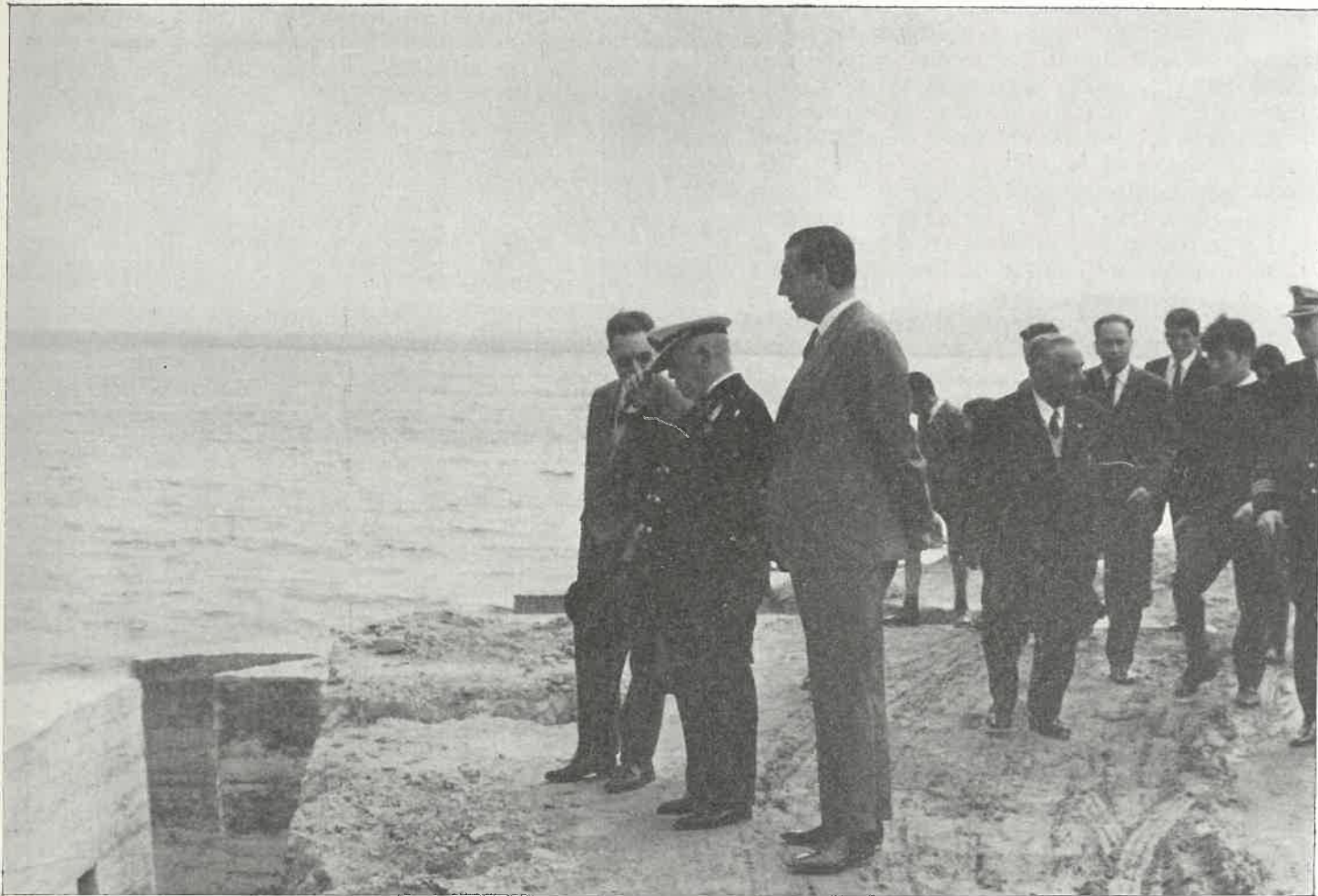
El Almirante, Gobernador y Presidente de la Diputación, contemplan las obras realizadas en los muelles, para la construcción del puerto de abrigo
