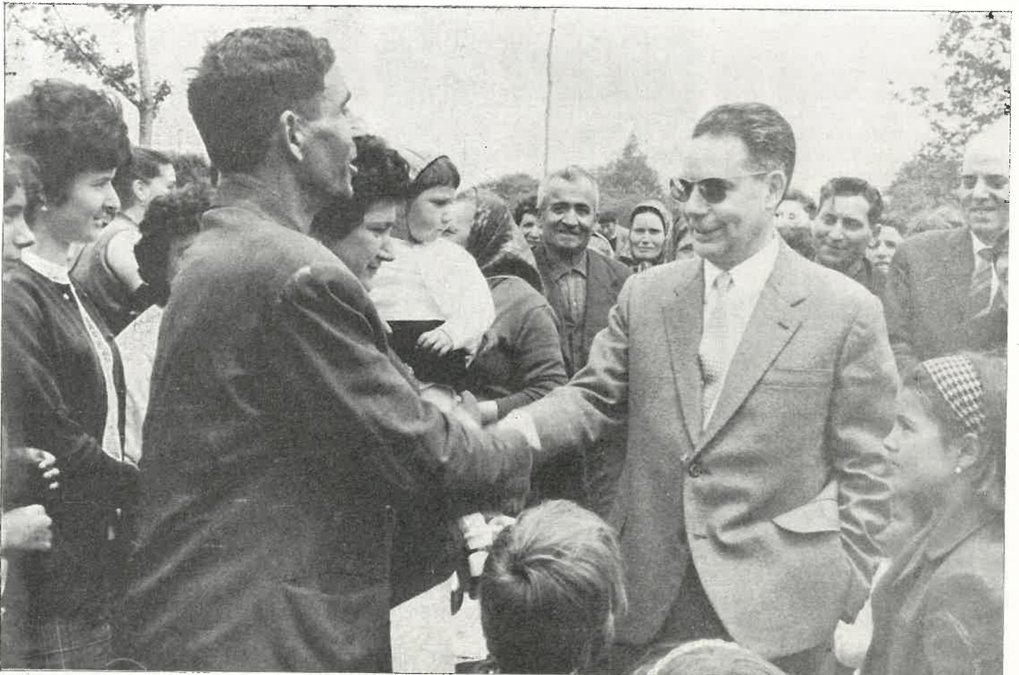
El Gobernador civil, Sr. del Río Iglesia, recibe la expresión de agradecimiento de un vecino de la parroquia donde fue inaugurado el servicio de alumbrado eléctrico
