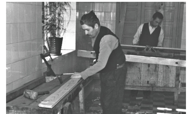
Obras no Hospital Psiquiátrico de San Rafael (s.d.) ADPL sig3331.108
