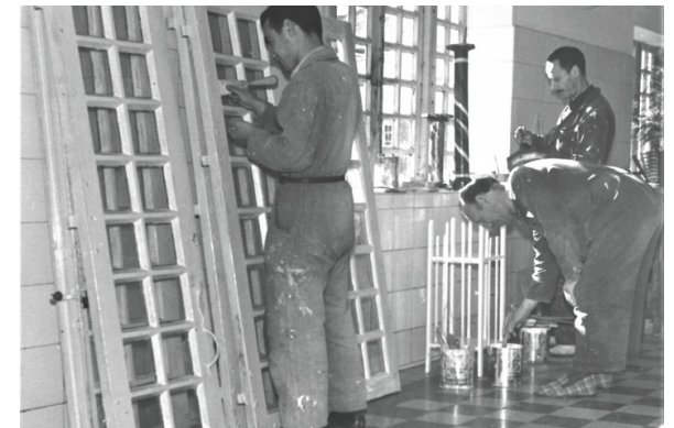
Obras no Hospital Psiquiátrico de San Rafael (s.d.) ADPL sig3331.106
