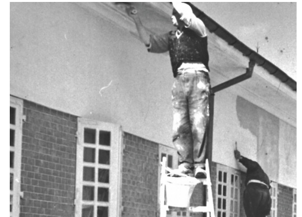
Obras no Hospital Psiquiátrico de San Rafael (s.d.) ADPL sig3331.107
